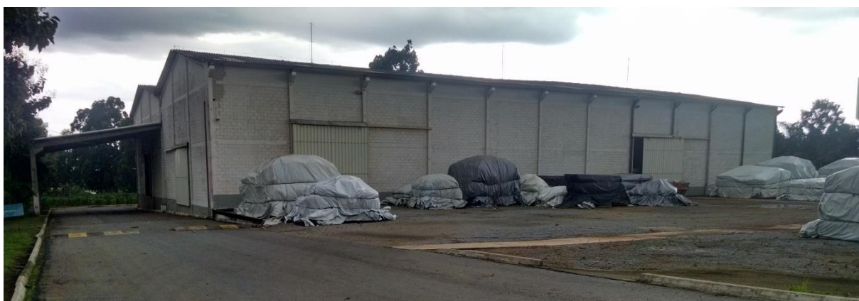
Figura 3 – Usina de beneficiamento de sementes, com resíduos ocupando o pátio.
